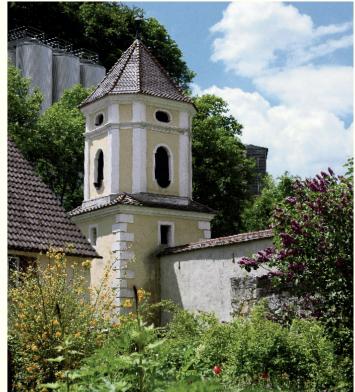
Ehemaliger Wasserturm des Klosters Zwiefalten
